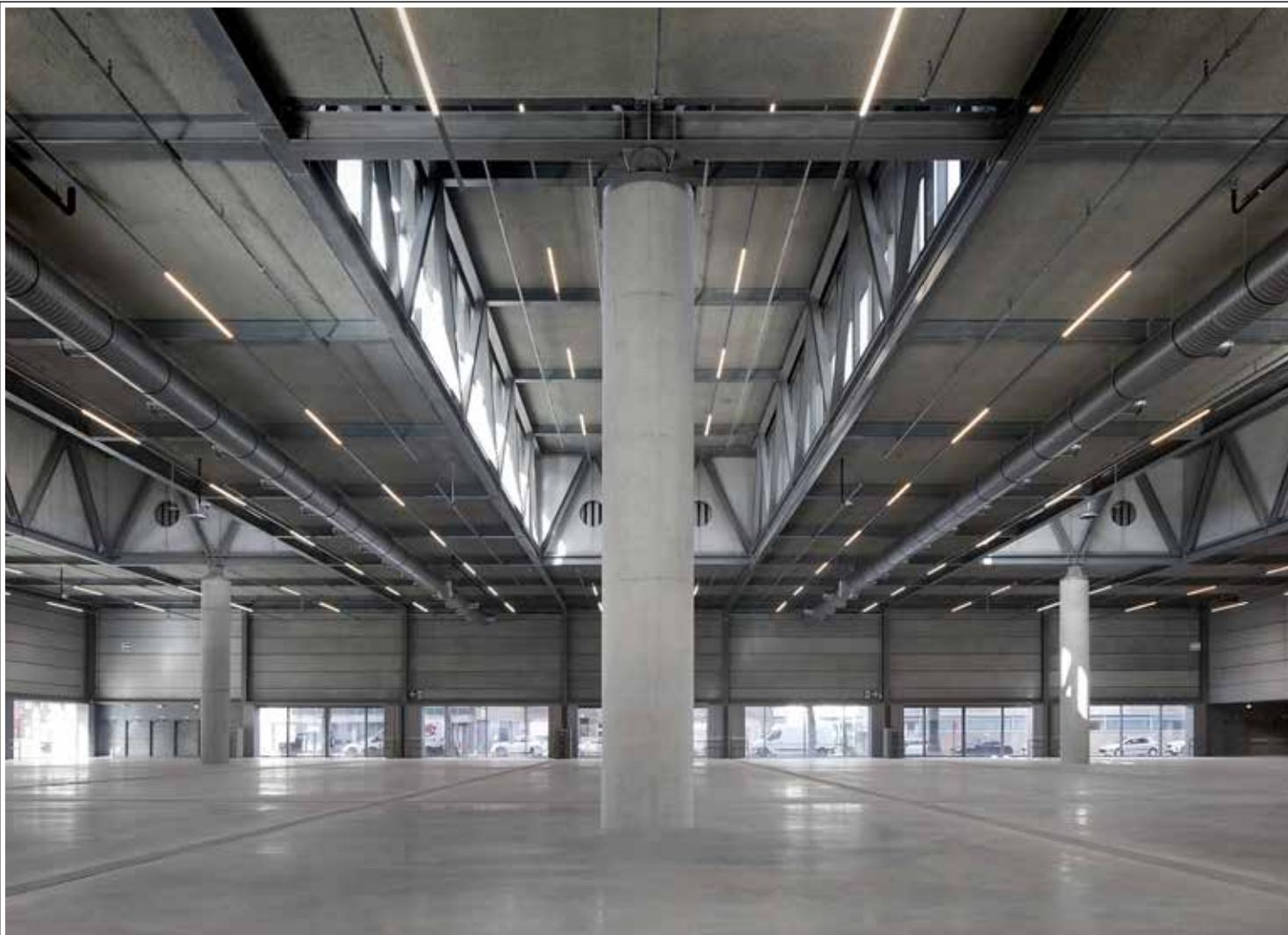
Zes secundaire en twee primaire stalen spanten brengen de lasten, via een architecturale scharnierende oplegging, over naar slechts zes betonnen kolommen (diameter 1,20 m).
